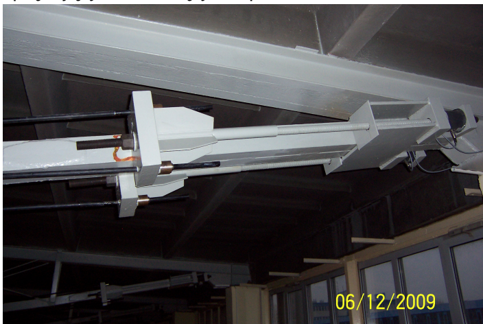
Fot. 2. Indywidualnie zaprojektowane pośrednie zakotwienie kabli.
