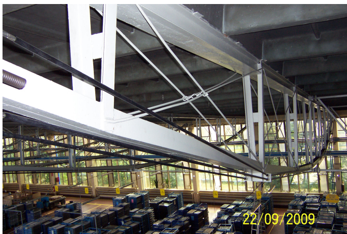
Fot. 1. Widok wzmocnionego dźwigara.
